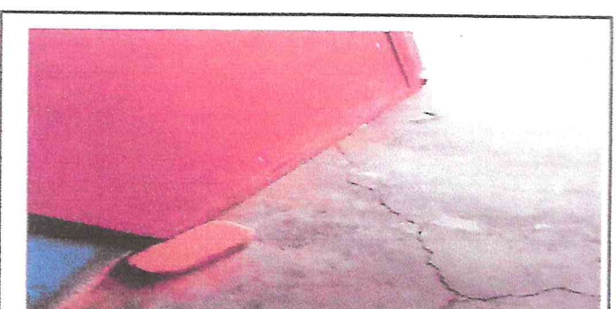
Foto 6: puertas para reparar
